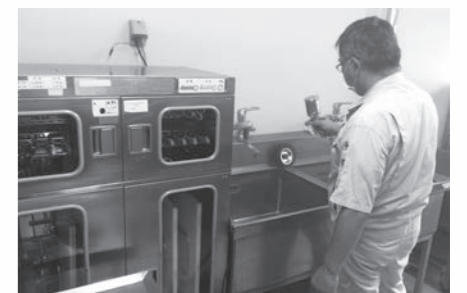
鹿屋養護学校(調理室)
